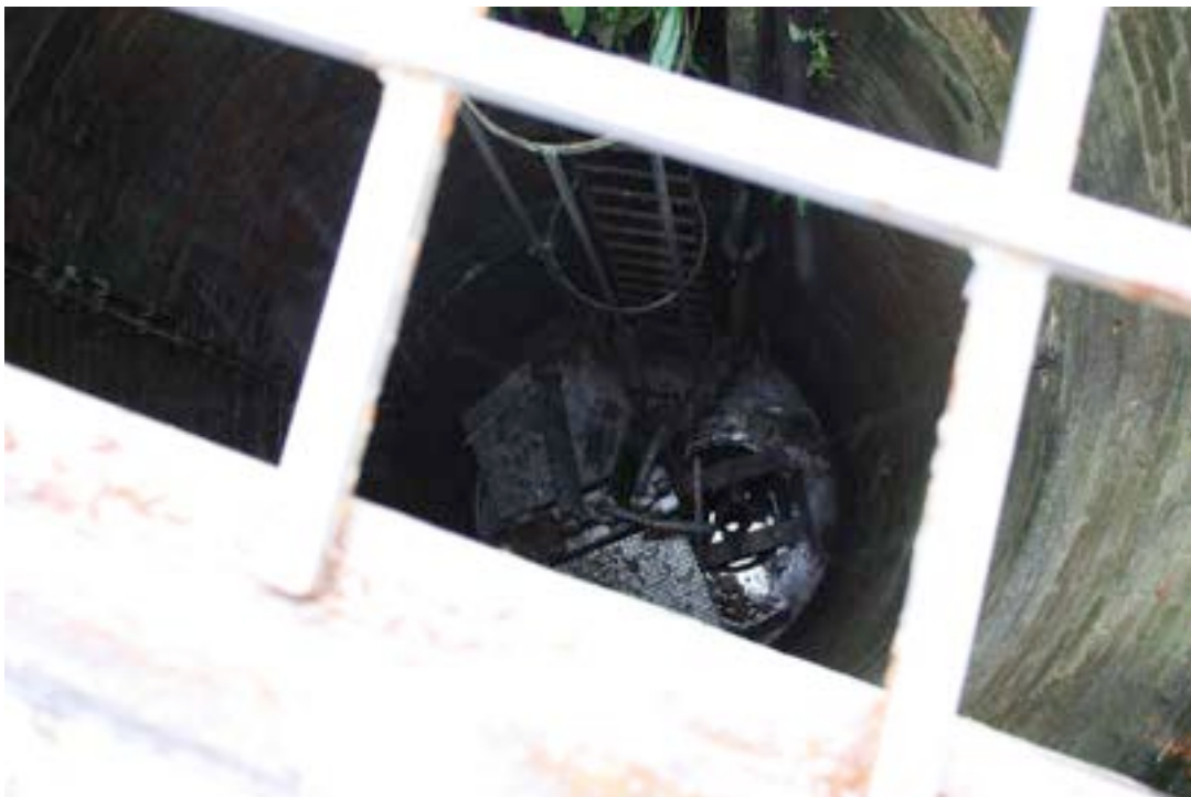
Bild Nr. 2: Detailfoto, in welchem das Mauerwerk und die Kreiselpumpe zu sehen sind
