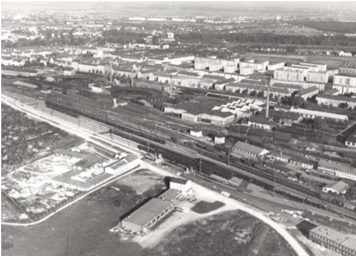
Bild Nr. 15: Luftaufnahme des Bw um 1960. Im rechten unteren Drittel des Fotos sind links eines langgestreckten Gebäudes mit Satteldach und daneben die hellen Baukörper des Wasserturms und des Süd-Stellwerks gut auszumachen. Auf Höhe des (undeutlich zu erkennenden) südlichen Rundhauses ragt der helle Turm der Besandungsanlage heraus. Weiter bemerkenswert: Auf dem Bw-Gelände entdecken wir vier hohe Schornsteine, wovon zwei an den beiden Rundschuppen ausschließlich für den zentralen Rauchabzug der Lokomotiven benötigt wurden. (Foto: Sammlung Erhart) Bw-Broschüre Seite 70.
