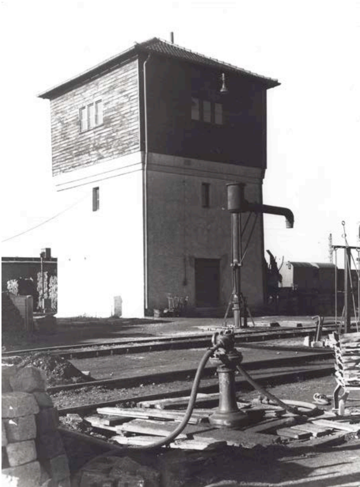
Bild Nr. 14: SW-Foto Erhart vom Wasserturm. Aus dem Dach ragt ein Schornstein, was bestätigt, dass auch in diesem spät erbauten Gebäude an den Frostschutz gedacht wurde.
